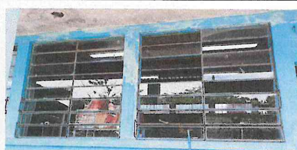
Foto 6: Sustitución de Estructura de metal y vidrios de ventana
