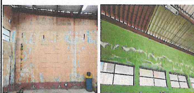
Foto 2: Pintura en muros interiores y exteriores
