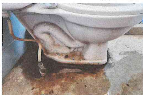
Foto 5: Sustitución de inodoro y accesorios, filtración constante del suelo debido a mala instalación,
