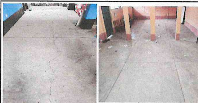
Foto 3: Sustitución de piso de cemento líquido
