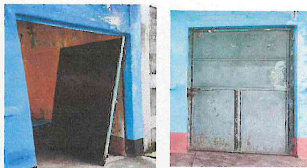
Foto 4: Mantenimiento a estructuras de puertas de metal y cambio de chapa
